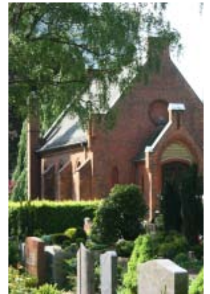
Friedhofskapelle von Hölscher erbaut 1890 Fotografie, 2005
